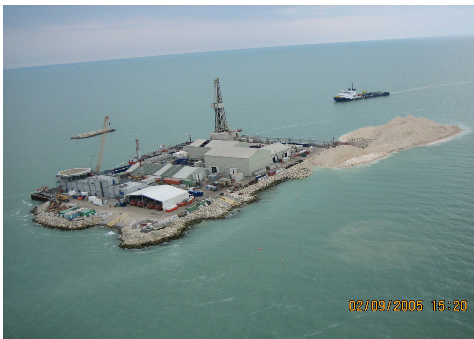
Рис. 2. Морские буровые установки: а) самоподъемные морские буровые установки СПБУ; б) морские буровые установки на отсыпных площадках
