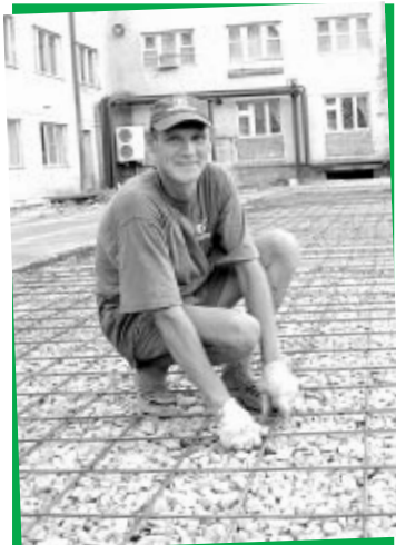
Бригадир А. Диденко на площадке с утра до ночи
